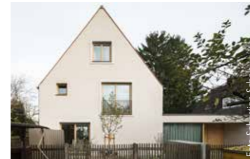
056 su und z Architekten
