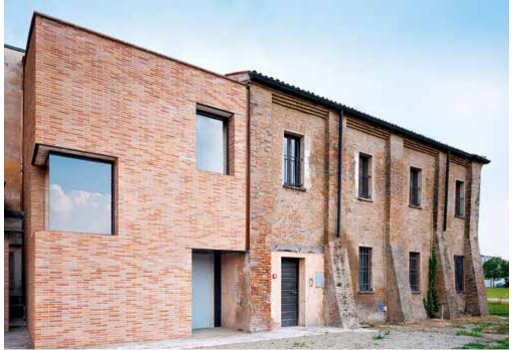
▲ Die Adaptation wird durch das neue Treppenhaus deutlich. Im Inneren nimmt die Betonschalung die Beschaffenheit des Backsteines wieder auf und führt diese abstrakt weiter.
