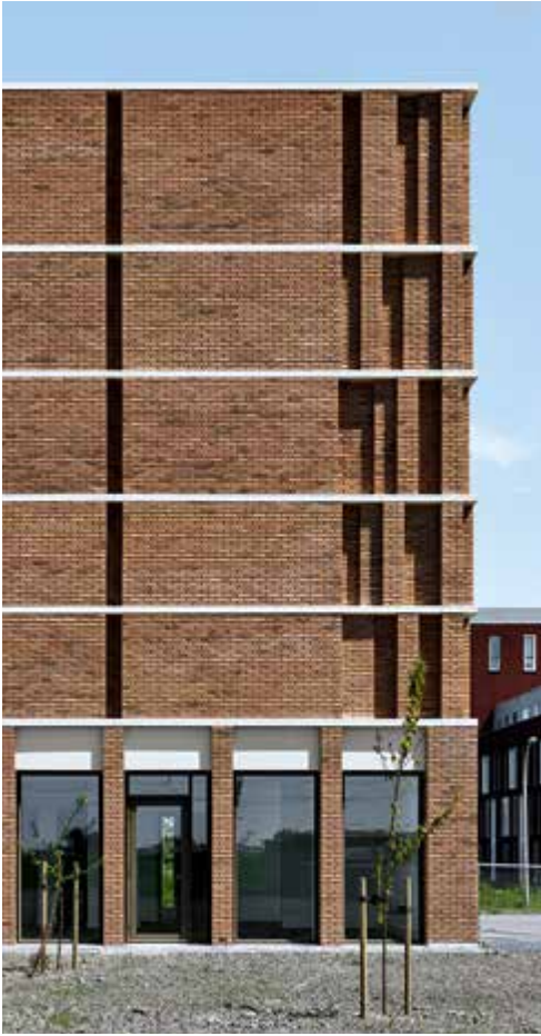
▲ Das Erdgeschoss dient als öffentlich zugänglicher Raum, die Obergeschosse als Archiv.
